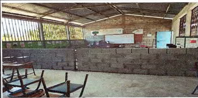
Foto 1: División de Aulas
