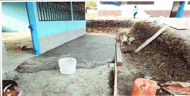
Foto 3: Colocación de piso
