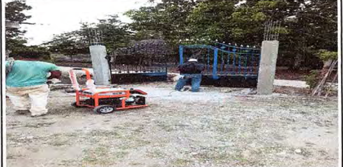
Foto 2: Colocación del porton
