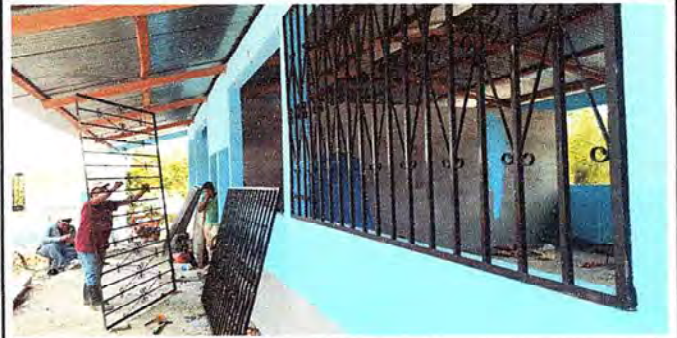
Foto 4: Colocación de balcones
